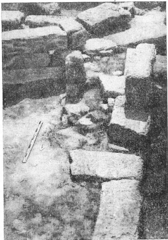
Рис. 7. Южная часть западного фасада куртины 212.
